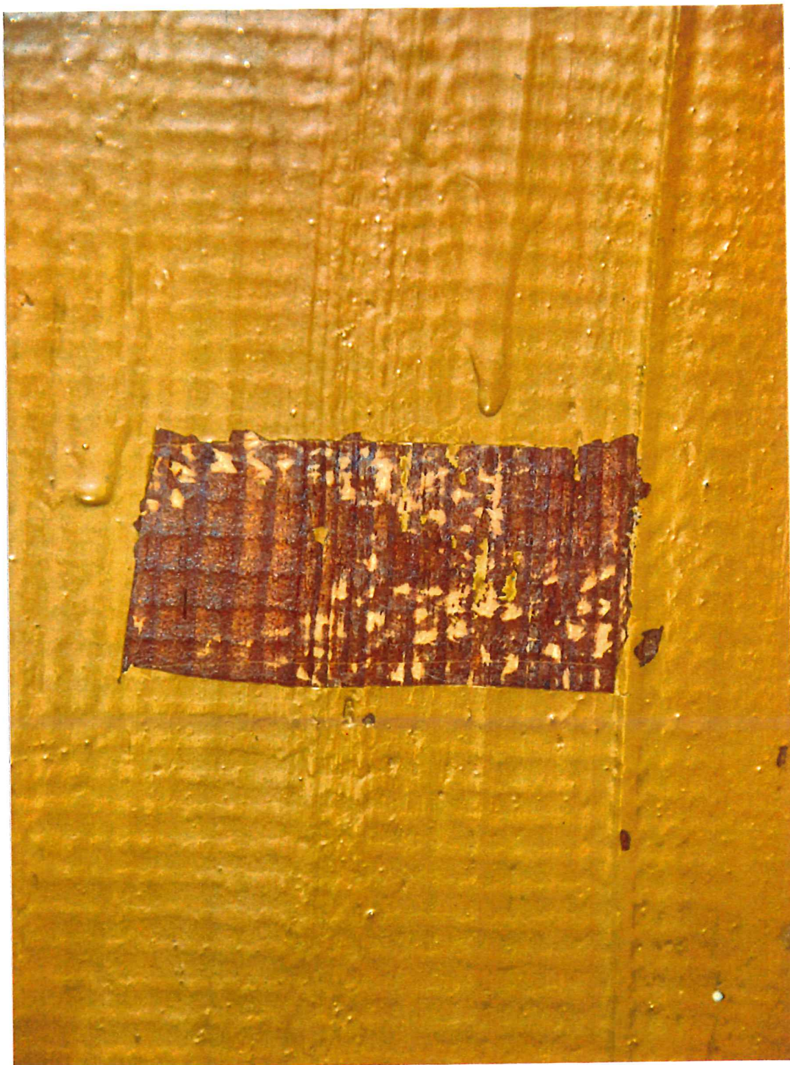
7. Ostrów, kościół parafialny pw. Najśw. Maryi Panny Królowej Polski, kruchta, 1923. Wnętrze przedsionka – odkrywka do warstwy pierwotnej. Stan zachowania przed wykonaniem prac renowacyjnych. 21.05.2024
